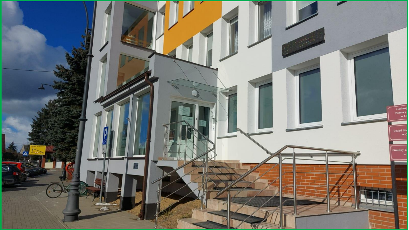
Nowe wejście do UG wraz z odmalowaną elewacją – fot. D. Góralski
