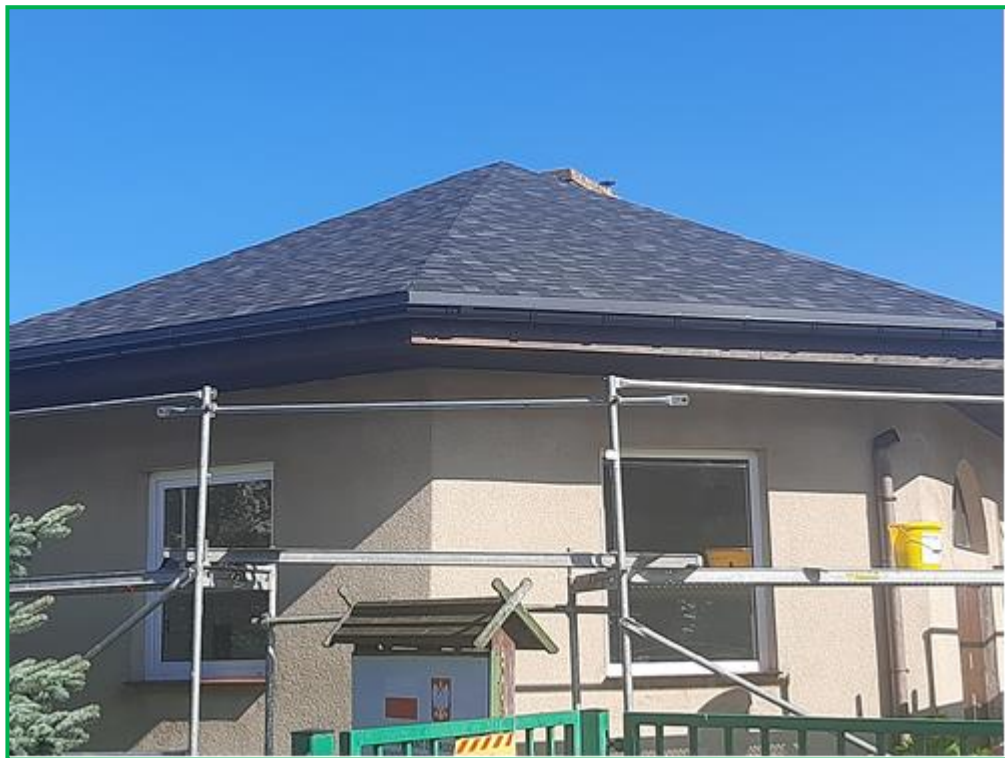
Nowe pokrycie dachowe na szatni w Cekcynie – fot. J. Wilkiewicz
