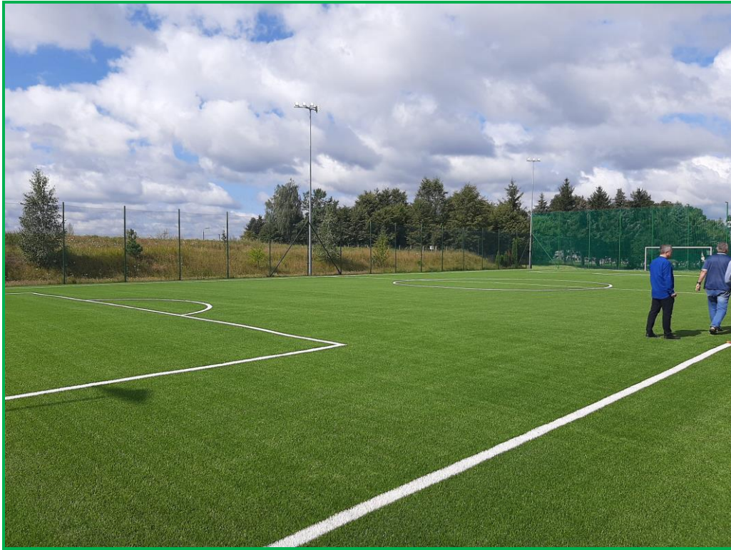
Zmodernizowana nawierzchnia na boisku Orlik w Cekcynie – fot. J. Wilkiewicz
