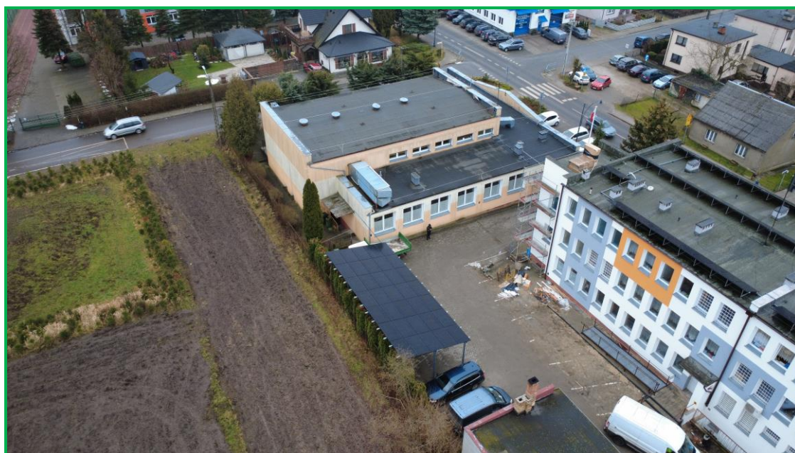
Wiata z paneli zasilająca GOK – fot. UG w Cekcynie
